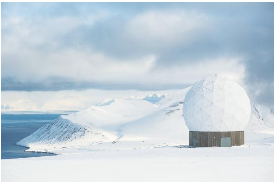
Photographie de la station satellite du Svalbard (Norvège), 2013.
